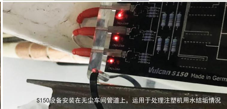
S150设备安装在无尘车间管道上，运用于处理注塑机用水结垢情况
